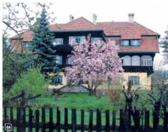
Ehemaliges Offizierswohnhaus, später Zeilingervilla.
