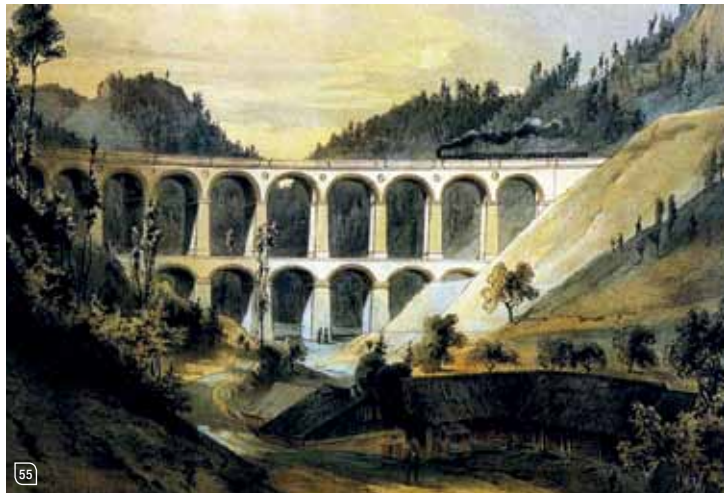
Viadukt – Kalte Rinne Semmeringbahn.
